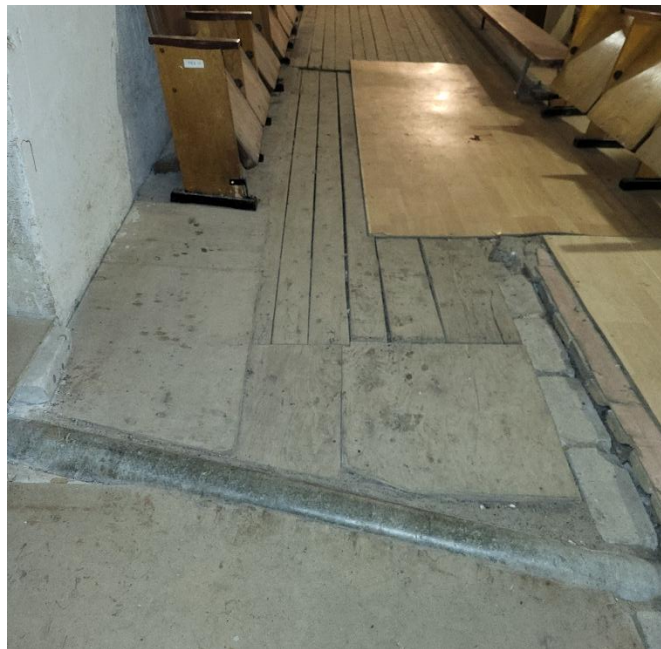
Рисунок 4 – Труба в підлозі підвалу
