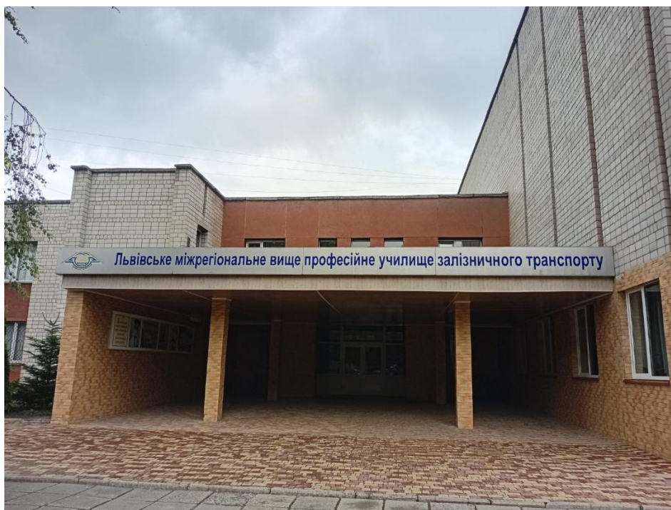
Рис. 3 Зовнішній вигляд адміністративної будівлі та виробничих майстерень
