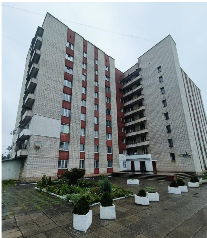
Рис. 2 Зовнішній вигляд будівлі гуртожитку
